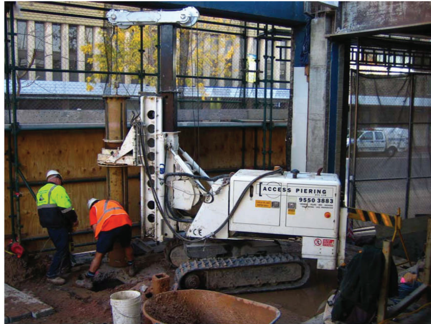
Image 3 – Mini piling rig
